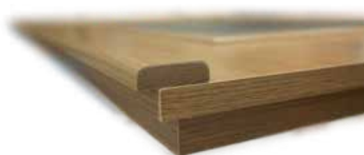
Krycí lišta dvoukřídlých dveří „klapačka“
